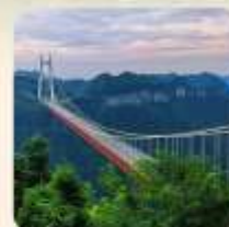
สะพานอ้ายจ้าย
