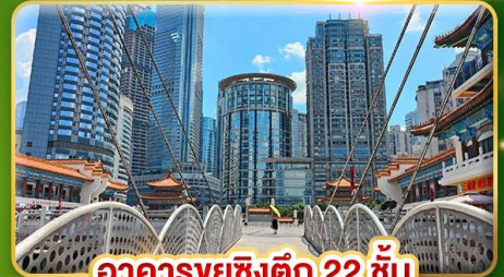
อาคารชวยซิงตึก 22 ชั้น
